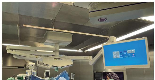
Figura 7-6. Disposición de lámparas de luz y monitor de imagen en un quirófano integrado.
