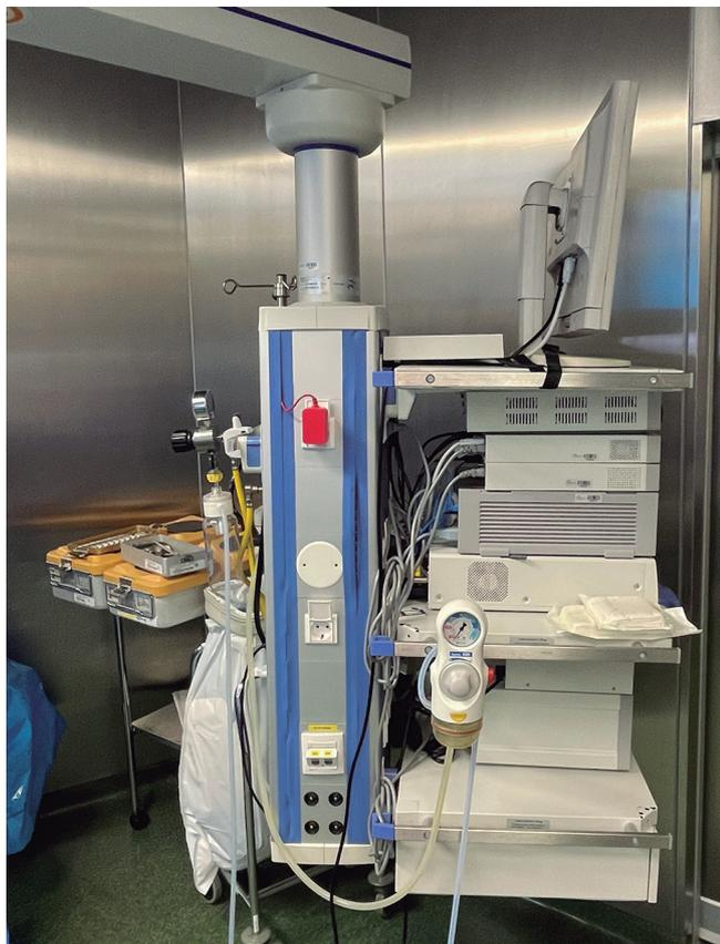
**Figura 7-7.** Torre de endoscopia sobre brazo articulado en un quirófano integrado.
