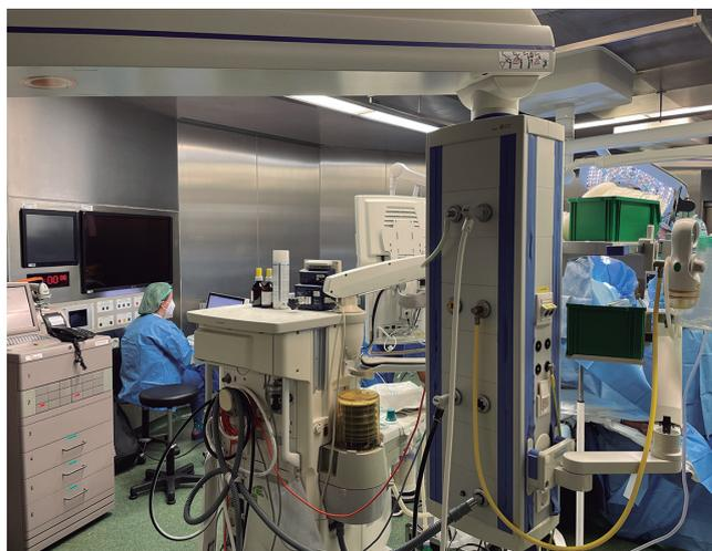
**Figura 7-9.** Carro de anestesia suspendido por brazo articulado.
